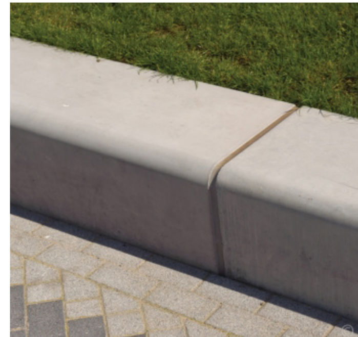
Impressie wadimuur, beton, breedte 50 cm
