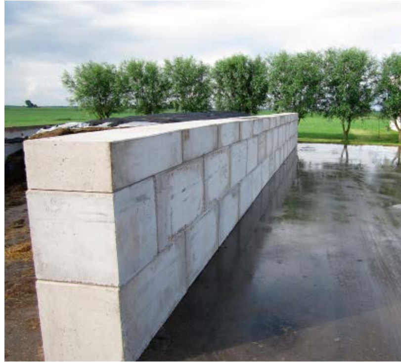
Muur van betonnen stapelblokken
