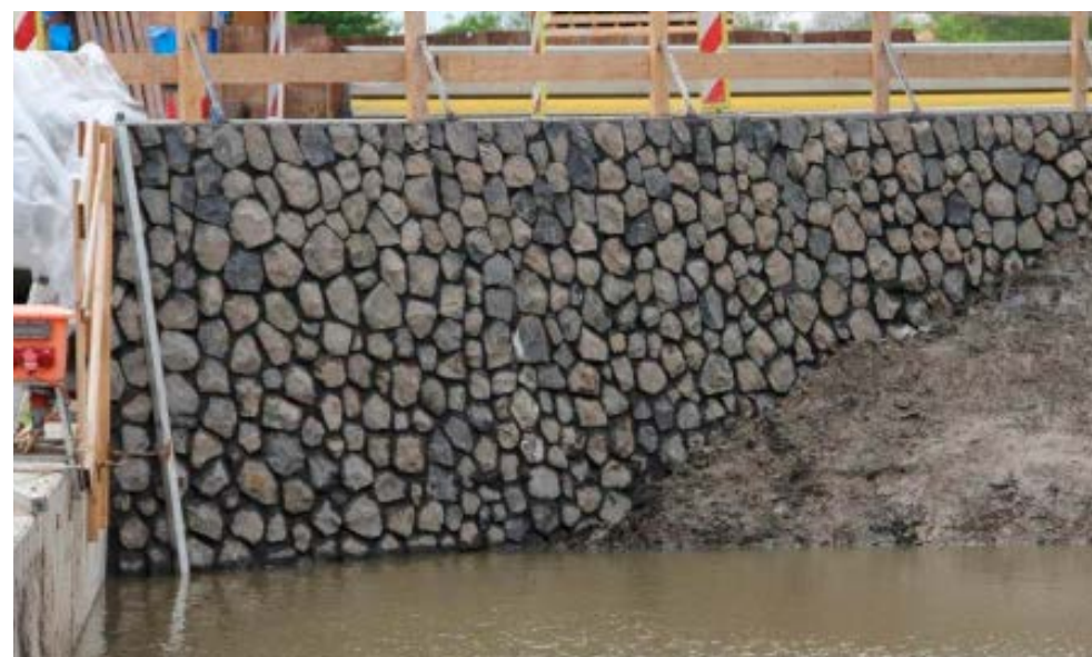
Keerwand van gemetseld basalt
