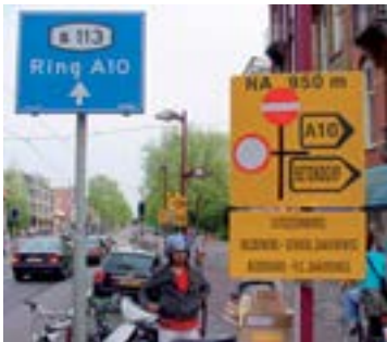
Het permanente bord had hier met tape afgeplakt moeten worden.
