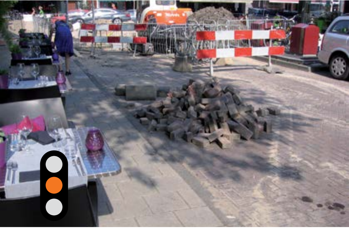
Houd bouwafval en materialen binnen de hekken.
