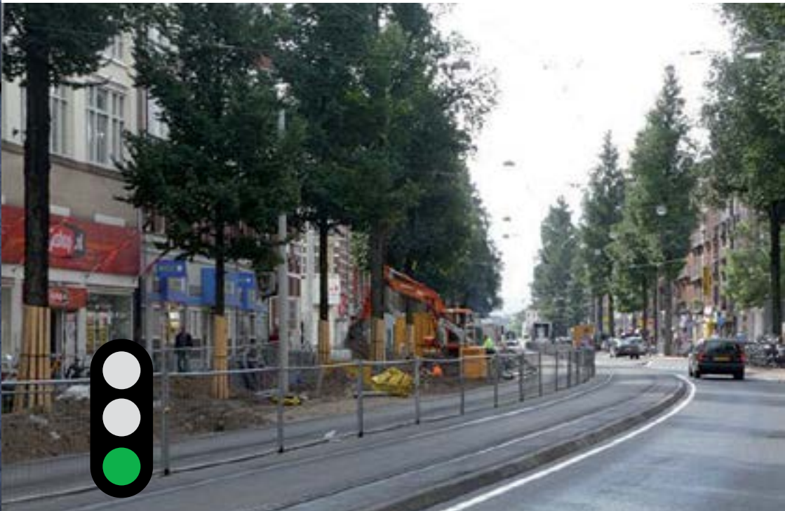
Gebruik altijd lage hekken of barriers bij een afzetting langs een trambaan.
