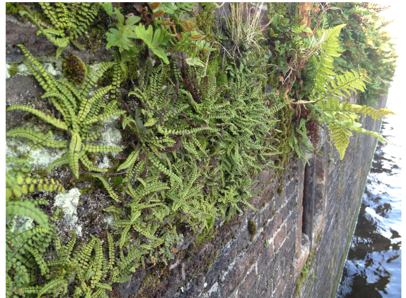
Groene kademuur Amstelsluizen
