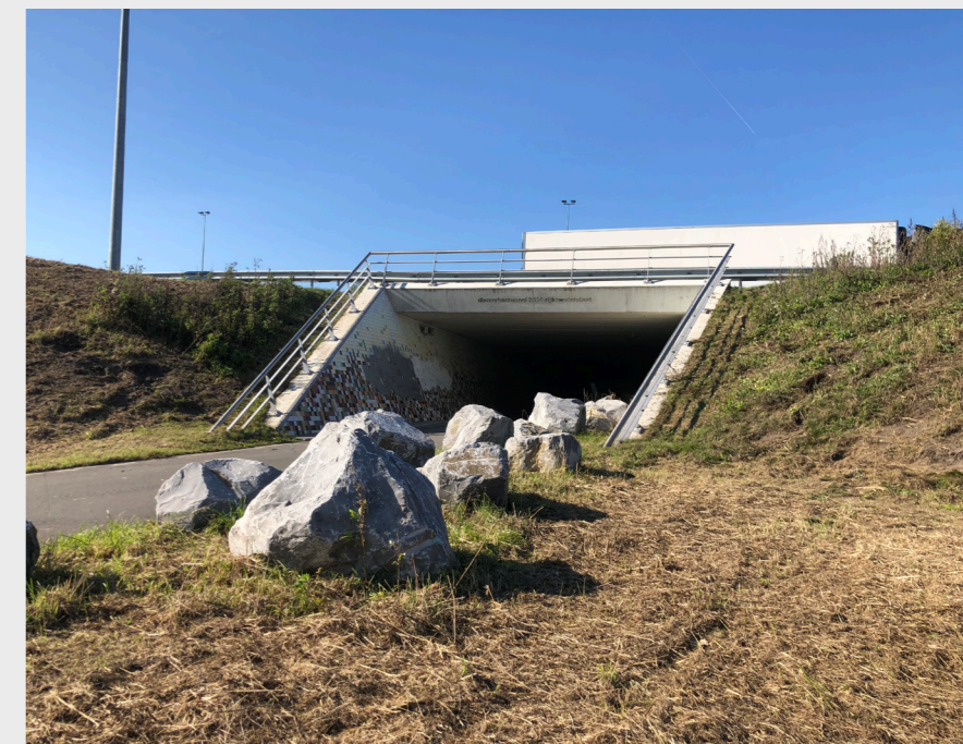
Voorbeeld van een faunapassage in een onderdoorgang
