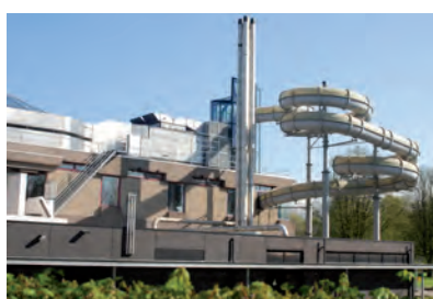
Bijzondere elementen zijn de gebouwen met meer complexe vormen
